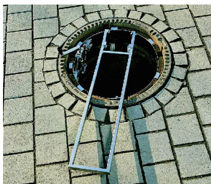
5. Provisorische Schachtabdeckung
